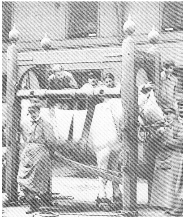
Figure 10 : Travail de Bourgelat sous le hall des hôpitaux d'Alfort (Pierre 1990)
